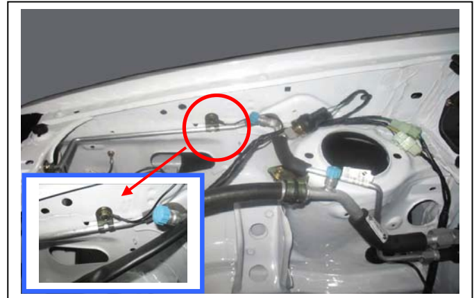
پیچ اتصال بدنه روی لوله فشار قوی گاز کولر
